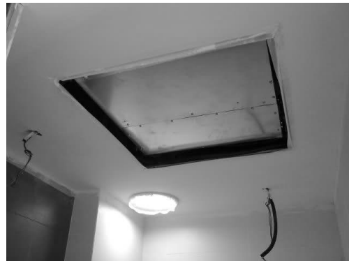
Foto: detalle de montaje y acceso de unidad evaporadora baja silueta.
