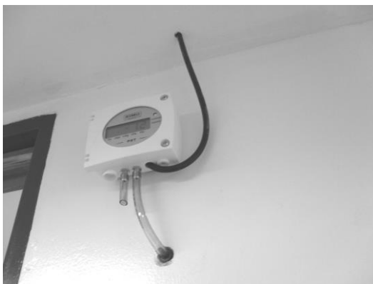
Foto: imagen de sensores de presión diferencial a ubicar en ambiente.
