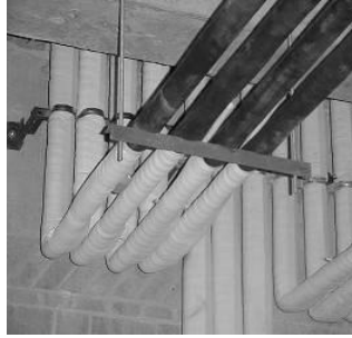
Foto: Ejecución correcta de montantes con aislación
