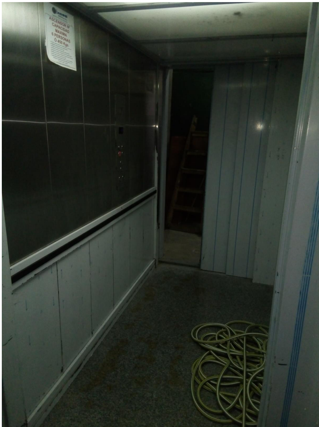
Fig: Ascensor existente Con doble acceso en Planta baja
