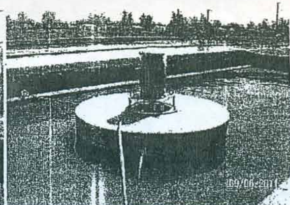
Aireadores de flujo horizontal y vertical
